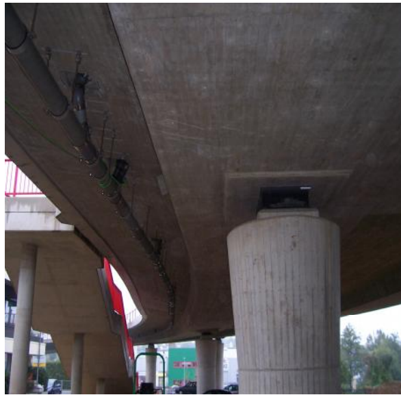
Betonarme köprü inşaatında
